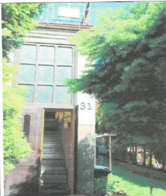
Wejście do budynku Pułaskiego 31
